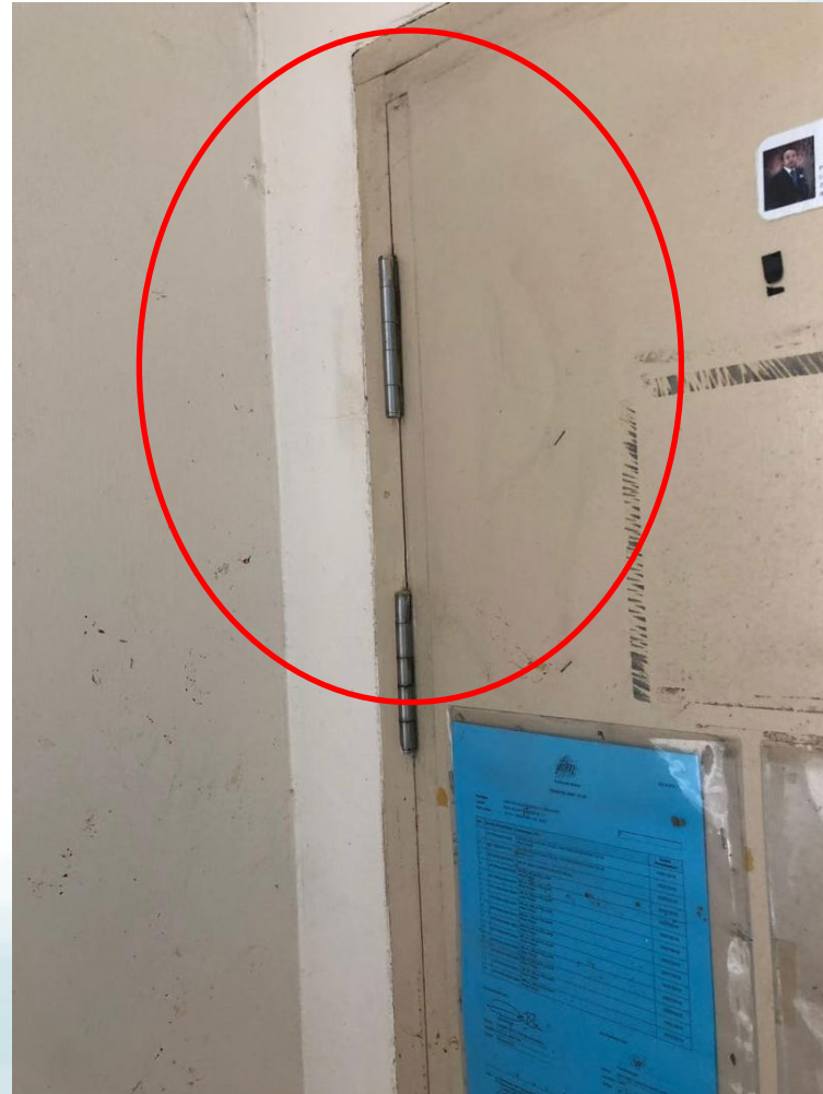
Penambahbaikan : telah dibersihkan
